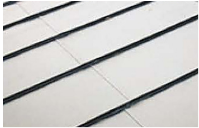
Plåttak förelås som materialval för tak.
